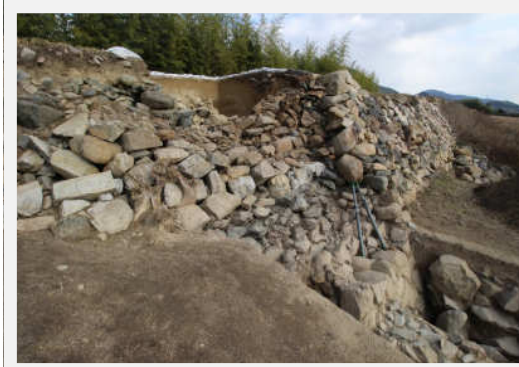
石垣の裏側から 新たに見つかった石垣
