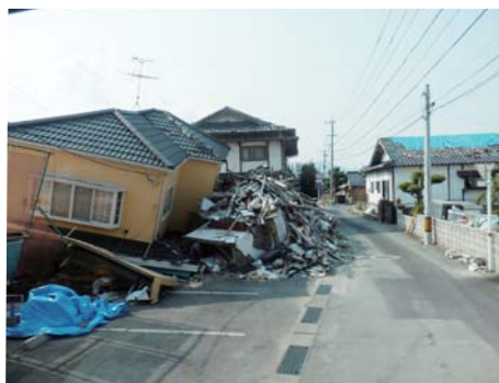
道を隔て被害状況の差
