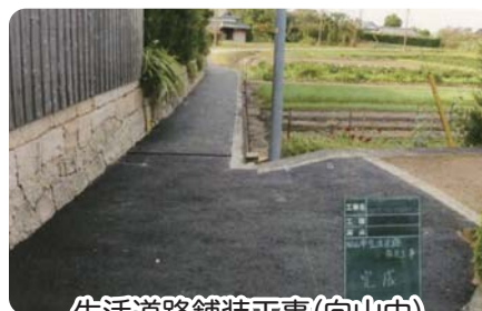
生活道路舗装工事(向山中)
