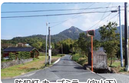
防犯灯・カーブミラー(向山下)
