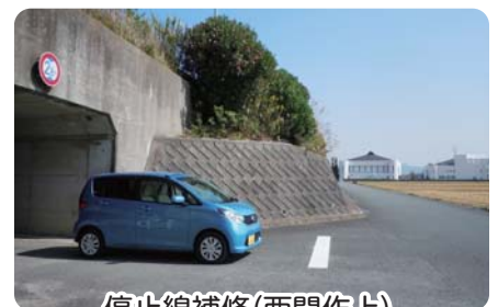
停止線補修(西開作上)
