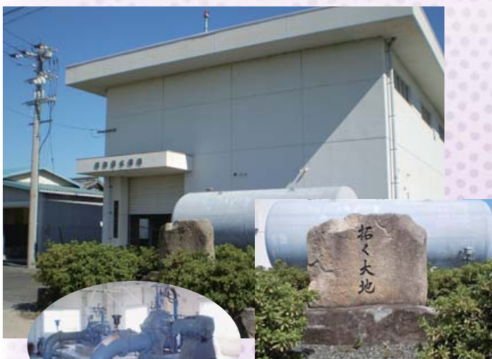
昭和揚水機場
