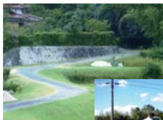
向山中施工前
