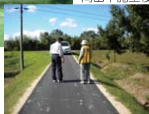
向山中施工後
