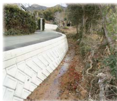
向山中水路補修工事完了
