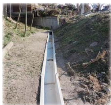
島上地区水路補修工事
