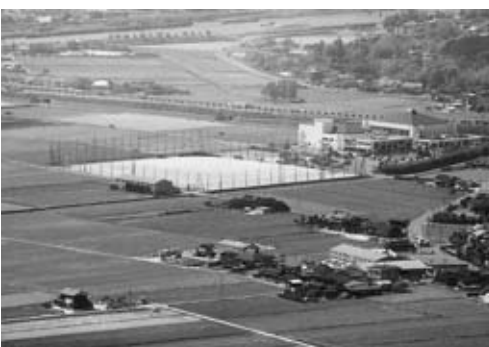
火の山から見た南総合センター
