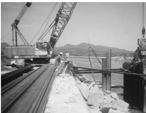
大極門の工事着々と
